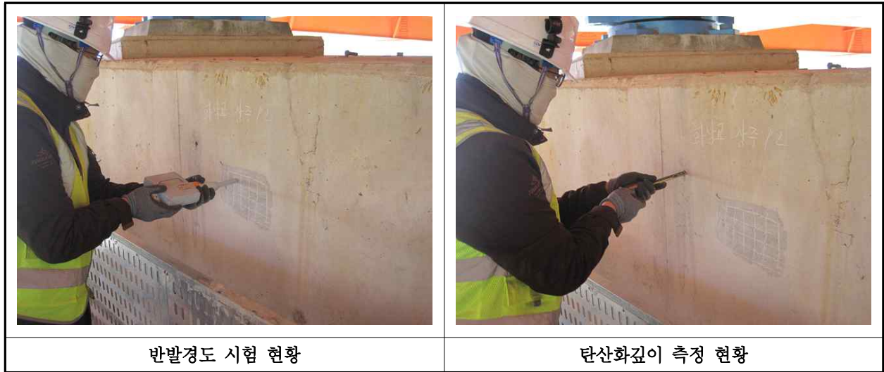
【사진 23.4.1】 콘크리트 내구성조사 현황
