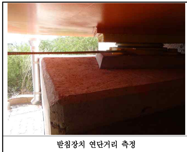
【사진 23.3.37】 교량받침장치 연단거리측정
