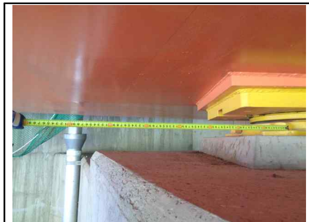
받침장치 연단거리 측정
