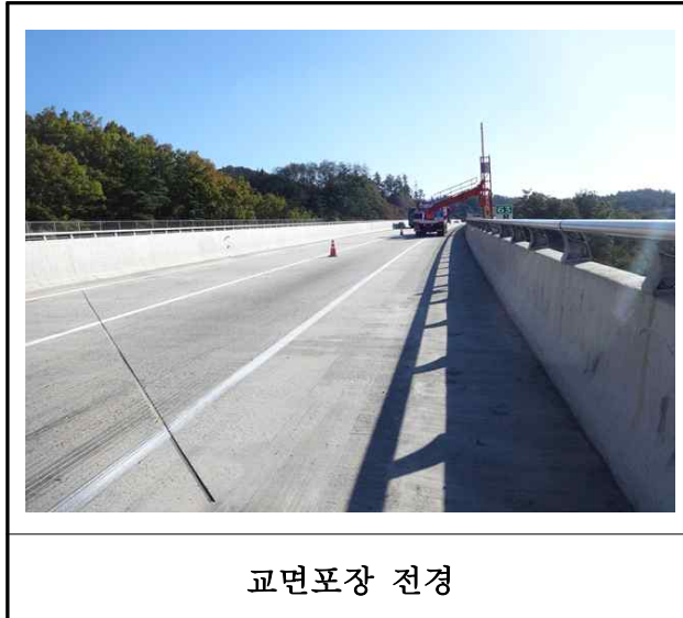
【사진 23.3.42】 교면포장 전경
