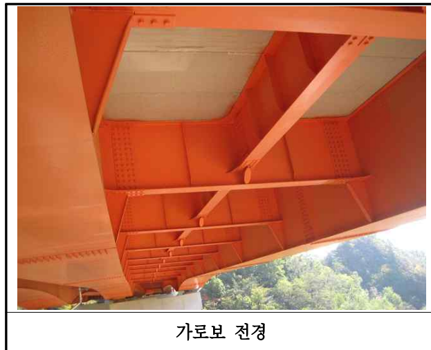
【사진 23.3.29】 가로보 전경
