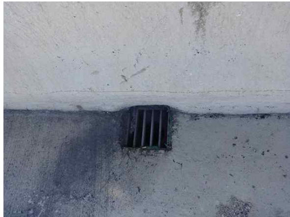
배수시설 상태 양호
