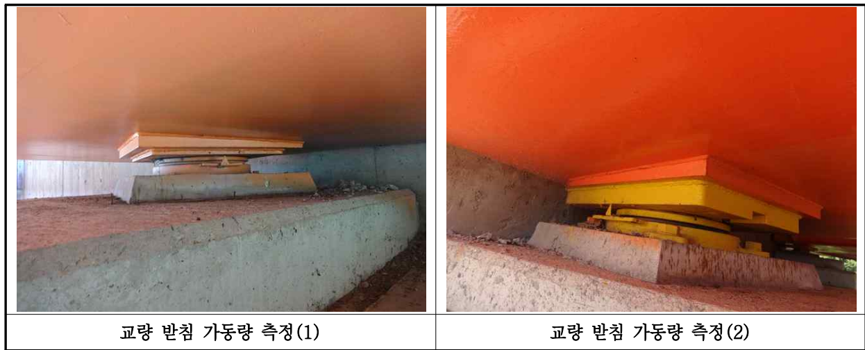
【사진 23.3.38】 교량받침 이동량 측정
