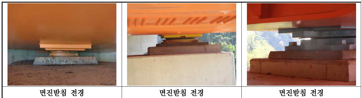
【사진 23.3.35】 교량반침 전경
