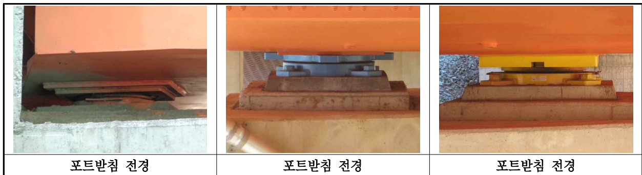
【사진 23.3.12】 교량반침 전경
