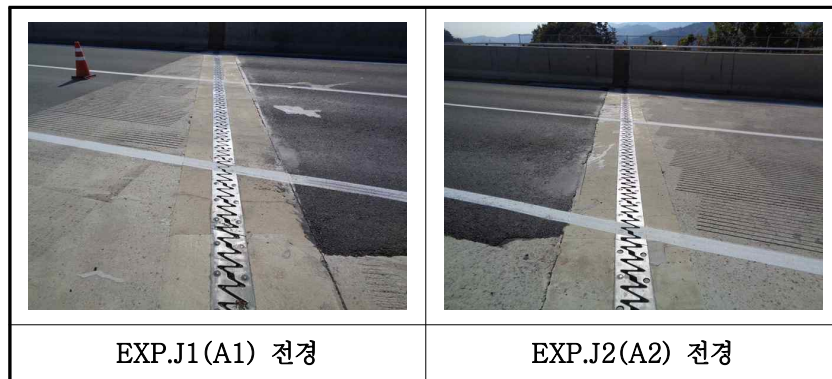
【사진 23.3.39】 신축이음장치 전경
